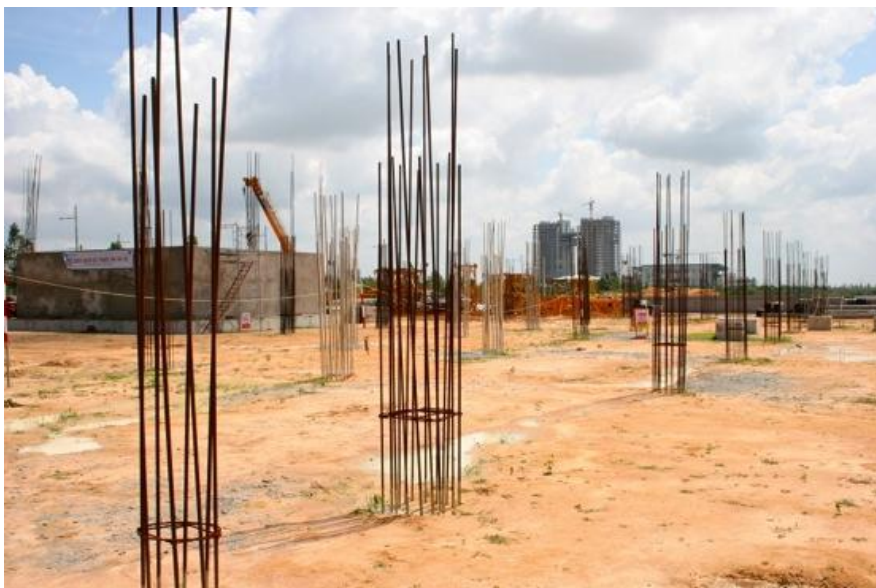
(「ソラ・ガーデンズ I」建設現場、昨年11月からの基礎工事が順調に完了し、本体工事に着手する)
